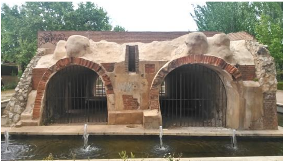
Figura 9. Horno Hoffman, en el parque levantado sobre las ruinas de la Fábrica de Cerámica Cermag.
